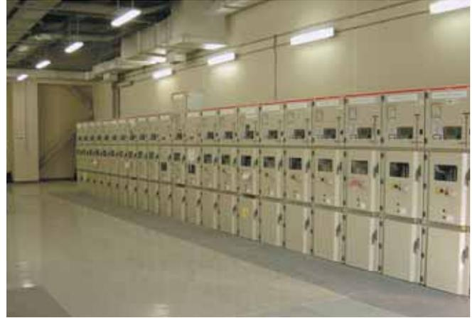
Trois unités de 2250 kVA à commandes principales numériques, résistances et panneau de mise à la terre du neutre, fournissent une alimentation de secours fiable à l'aéroport.
