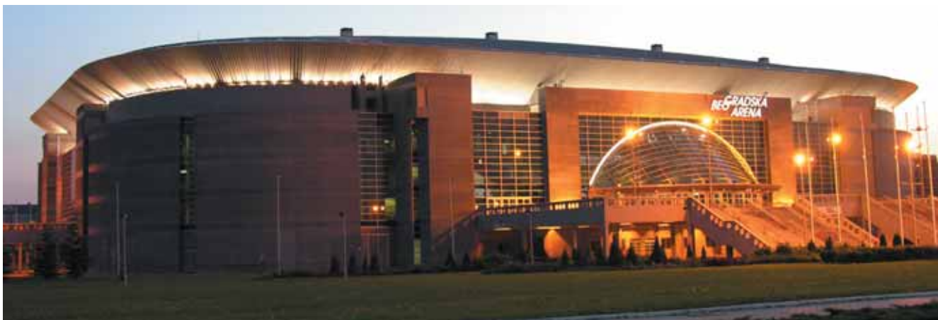
Quatre groupes électrogènes de 500 kVA, en deux paires, chacune assurant l'alimentation de la moitié du stade.
