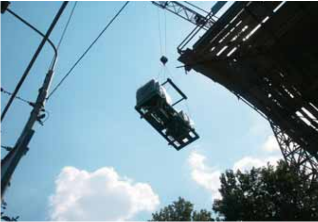
Le grand groupe électrogène a été installé par étapes dans le sous-sol du théâtre.
