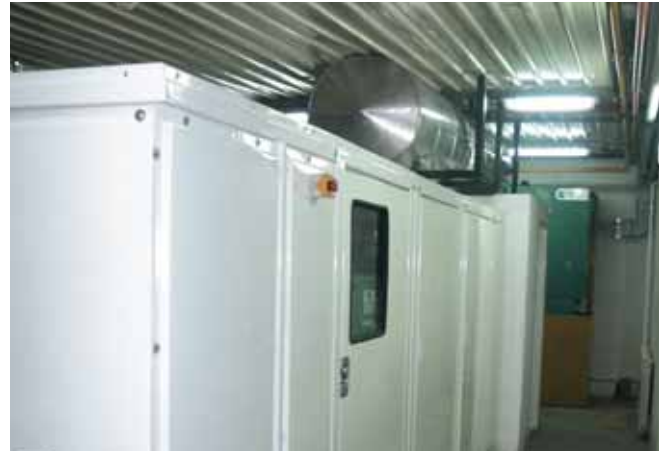
Le niveau sonore des générateurs abrités dans le sous-sol est limité par une enceinte insonorisée.
