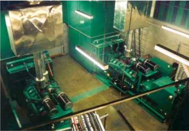
La salle du générateur comprend des systèmes de contrôle poussé du bruit et des émissions.
