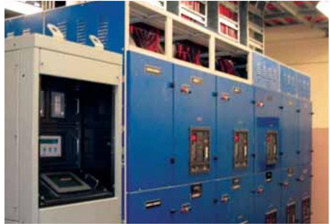
Le système de contrôle numérique principal PowerCommand MC 200 synchronise le fonctionnement des groupes électrogènes.
