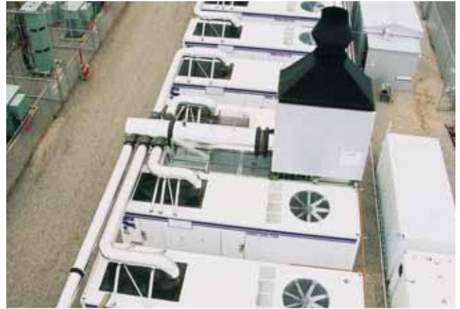
La centrale utilise la technologie la plus récente pour les systèmes catalytiques de réduction des émissions, garantissant des émissions NO<sub>x</sub> au sol inférieures aux normes australiennes prévues pour 2008.
