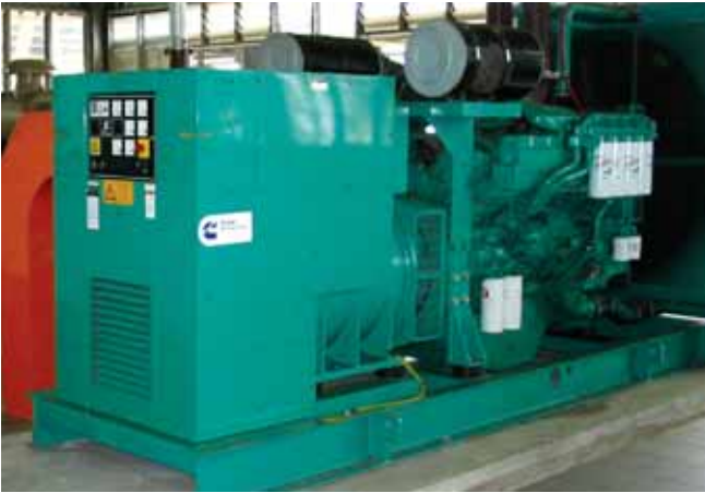
Les groupes électrogènes Cummins Power Generation sont en partie utilisés pour démarrer la chaudière pour la turbine à vapeur.
