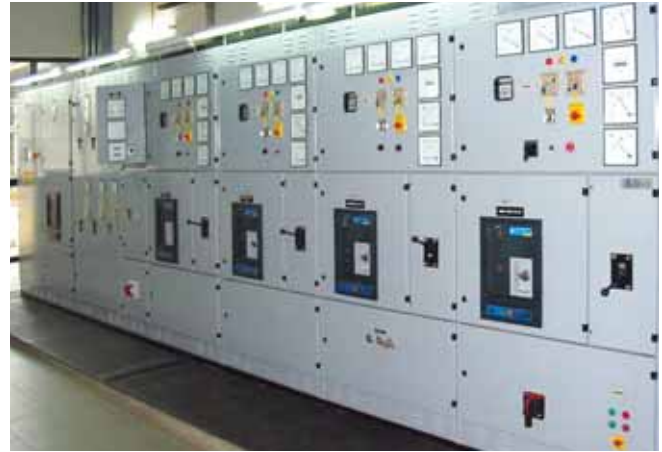
Le tableau de contrôle automatique en parallèle synchronise les groupes électrogènes et la turbine à vapeur.
