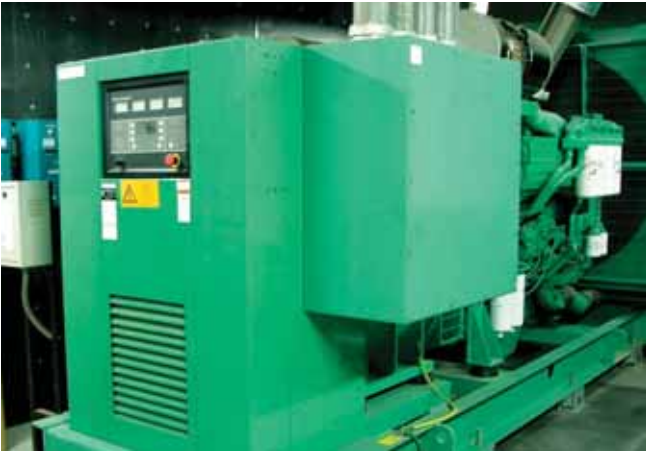
Les groupes électrogènes Cummins Power Generation assurent l'alimentation d'urgence du Stade national My Dinh.
