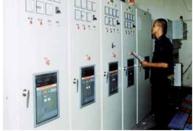
L'équipement de connexion en parallèle assure la synchronisation des groupes électrogènes et de l'alimentation secteur.
