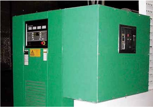
La gamme de groupes électrogènes Cummins Power Generation assurent une alimentation de secours fiable à la chaîne Tesco Lotus.
