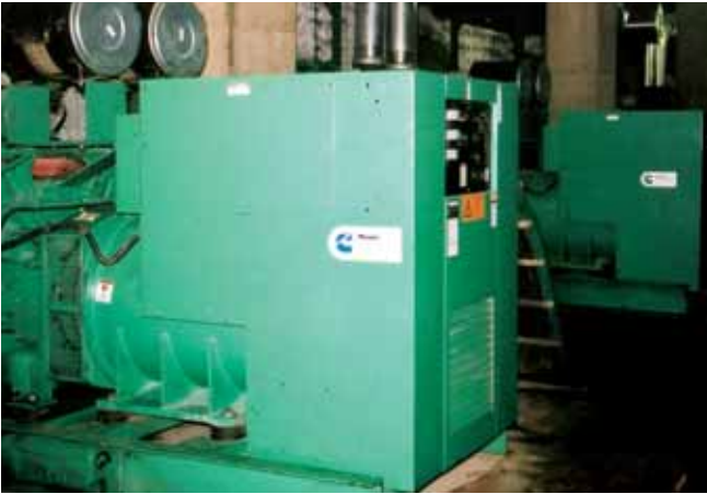
Cinq groupes électrogènes Cummins Power Generation fonctionnent tous les jours pour alimenter la galerie marchande en électricité.
