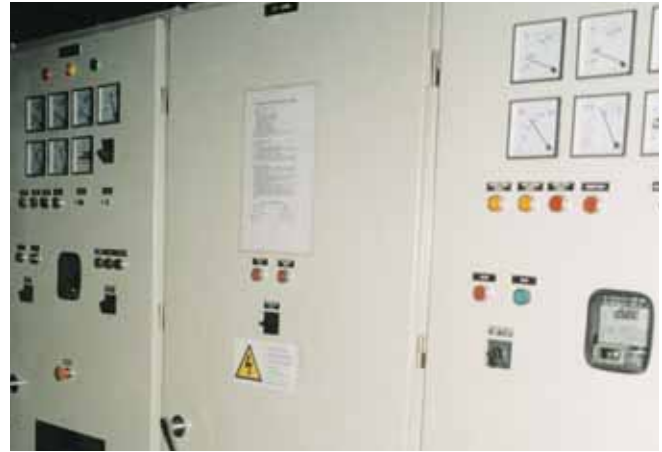
L'équipement de connexion en parallèle garantit une utilisation optimale des groupes électrogènes en fonction des critères de charge.
