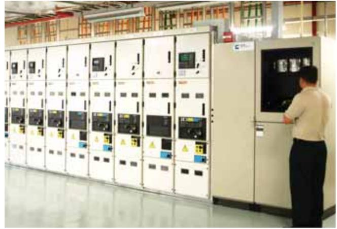
Le système de commande de pointe PowerCommand de Cummins Power Generation et l'ATS garantissent un transfert de charge dans les 20 secondes.
