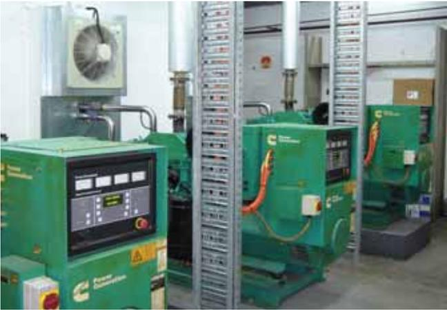
Le système de production d'énergie entièrement intégré utilise trois groupes générateurs du système de production électrique Cummins Power Generation, le matériel numérique en parallèle Cummins PowerCommand, et un système de contrôle numérique maître Cummins qui est intégré dans un nouveau tableau de mise en parallèle et de distribution.
