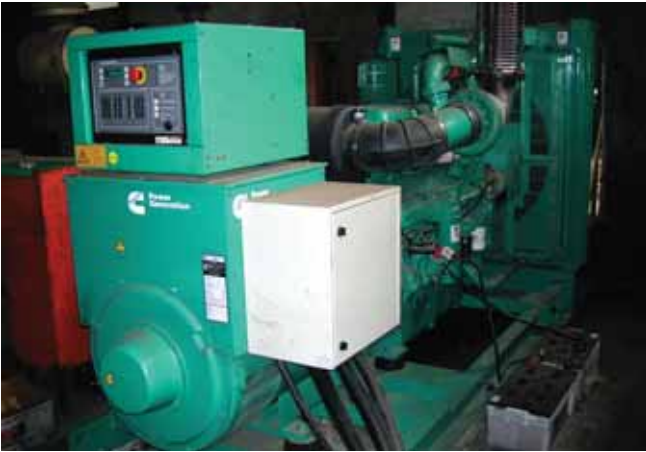
Groupe électrogène C550 D5 installé et prêt à être mis en parallèle avec la turbine à vapeur.
