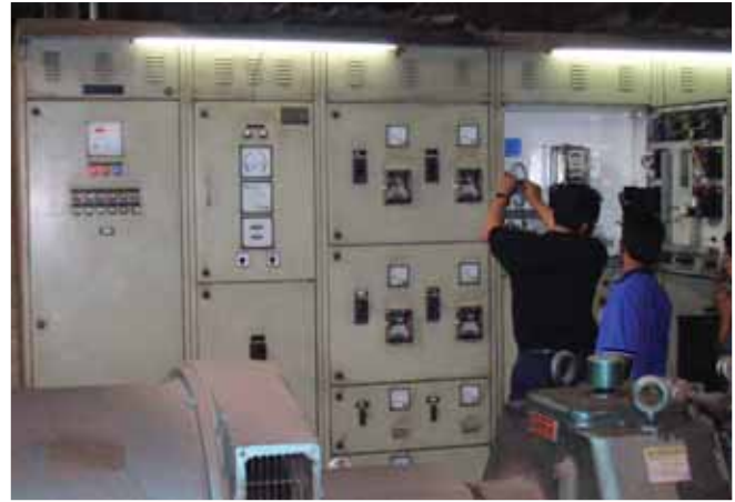
Les techniciens mettent la touche finale au câblage de commande.
