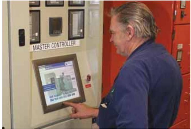
Le système de production électrique Cummins DMC 200 fournit aux opérateurs de la salle mécanique une interface à écran tactile facile à utiliser, pour surveiller les générateurs, ainsi que la charge et le statut du système.
