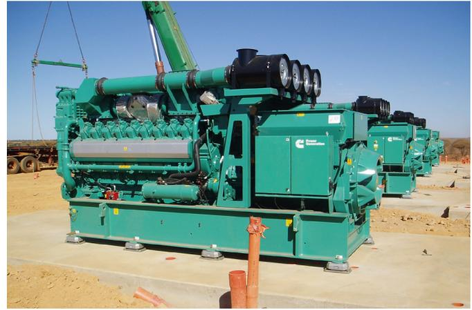
Les groupes électrogènes au gaz sont entraînés par des moteurs à gaz Cummins à charge stratifiée au gaz et allumage par étincelle, ce sont des unités de 91 litres, V18, avec turbocompresseur et post-refroidissement.
