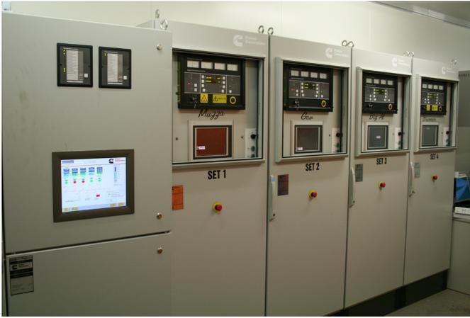
Un système de commande numérique principal DMC300 de Cummins Power Generation gère la demande de la charge de toute la centrale.
