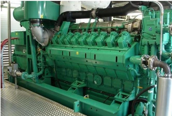
Les principaux avantages du groupes électrogènes modèle QSV91 à moteur à charge stratifiée au gaz incluent la combinaison d'une meilleure économie de carburant, d'une production de puissance élevée et de faibles émissions de NOx.
